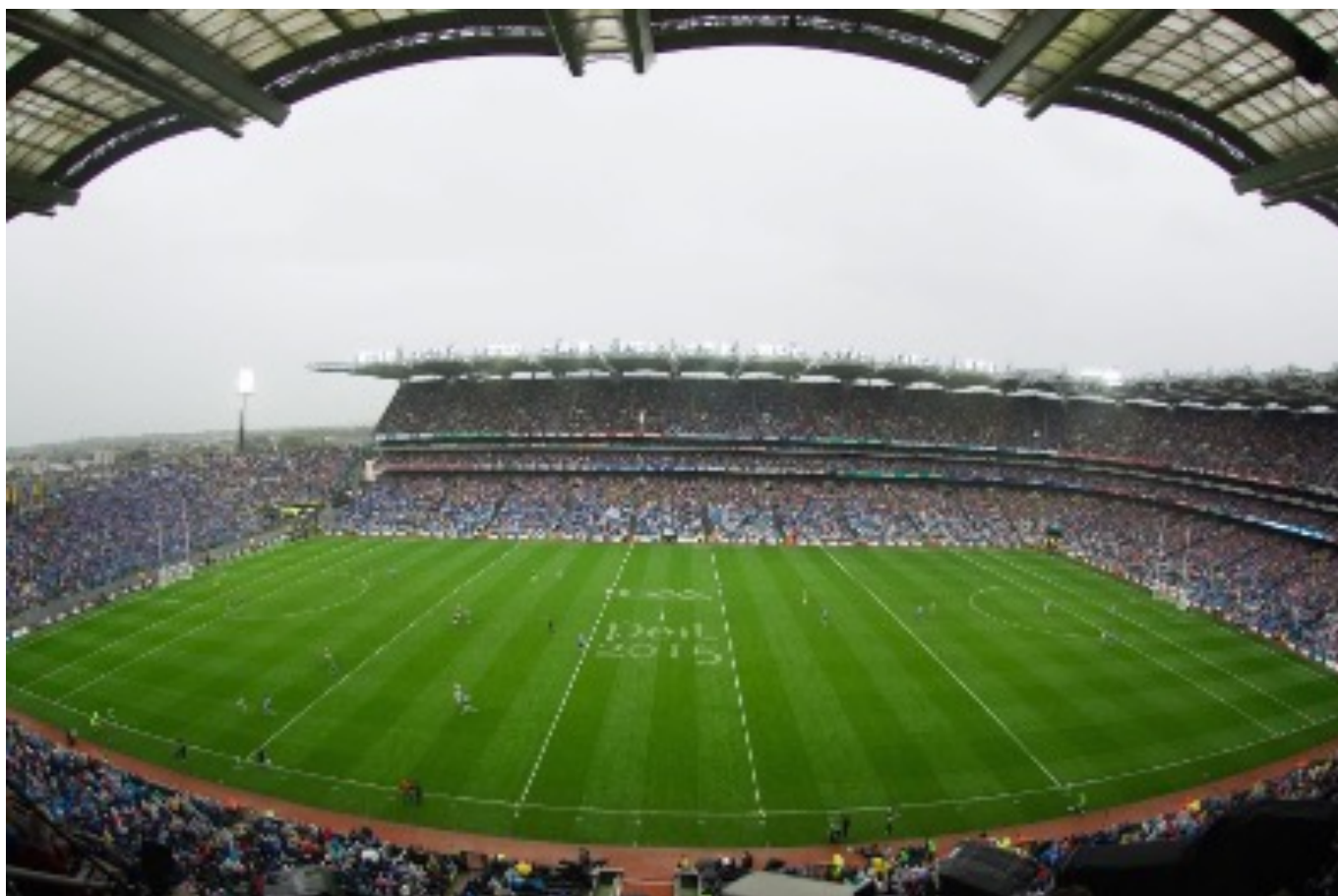
Il Croke Park di Dublino dopo la ristrutturazione
